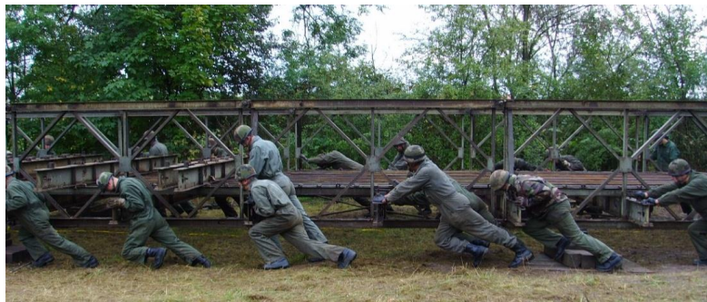
La formation à la construction du pont Bailey (ici, un montage S-S) est toujours d'actualité.
