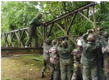
La formation à la construction du pont Bailey (ici, un montage S-S) est toujours d'actualité.
