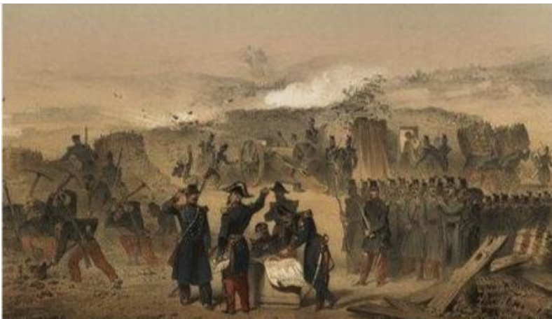
Gabions et claies, accessoire indispensables à la réalisation des ouvrages de siège depuis Vauban.
