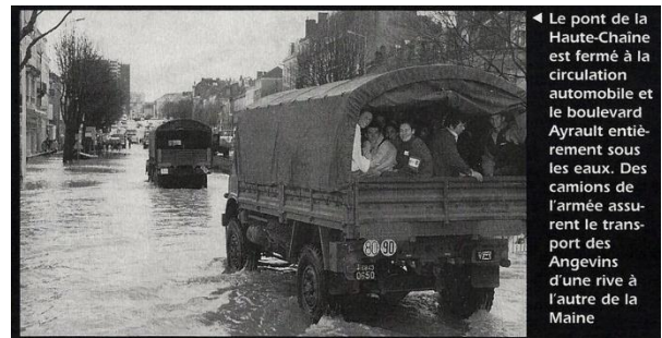
Inondation Angers 1995 a.jpg (camion pont de la haute chaîne)
